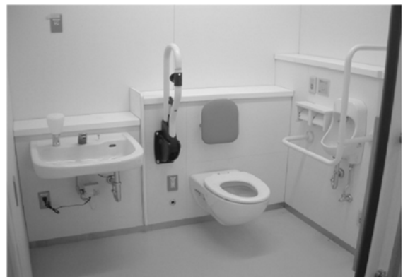
図-3 多目的トイレ Fig.3-Multi-purpose restroom.
