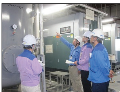
富士通セミコンダクター(株)グループ施設計画部による安全点検(会津工場)
