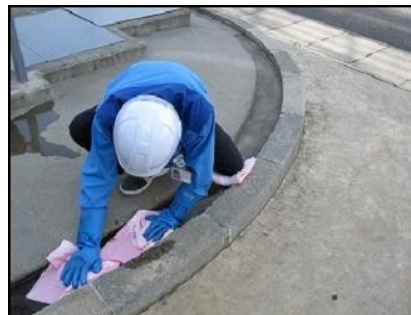
重油漏洩・流出防止処置訓練(会津)
