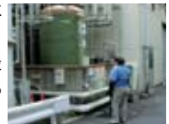
薬品供給タンク防液堤(漏洩防止)の点検
