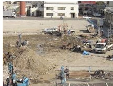
土壌調査 ボーリング調査 (富士通川崎工場)
