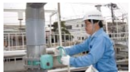
廃水処理場(富士通川崎工場)
