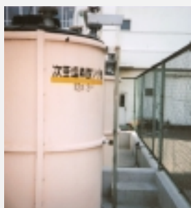
排水処理施設内の防液堤(川崎工場)
