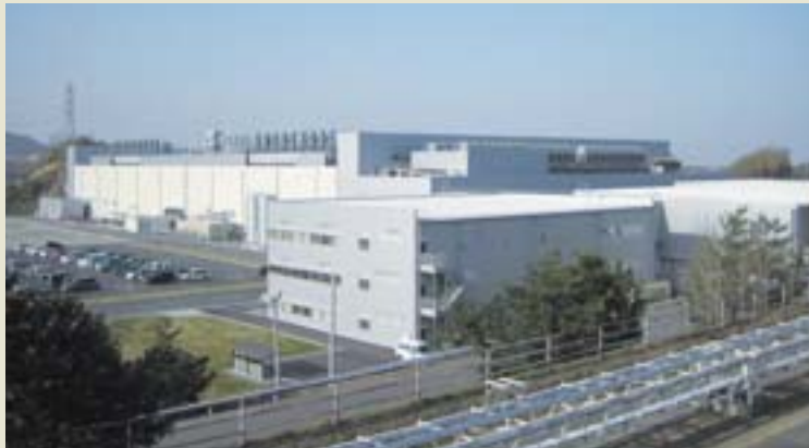
三重工場新棟
