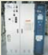
PFC除害装置
